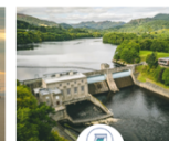
Hydroélectricité 1459 MW en exploitation
